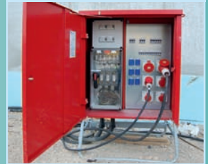
Baustromverteilerschrank
