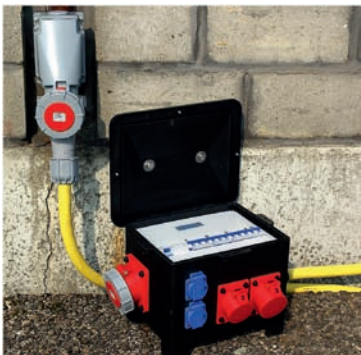
Abb. 8 Mobiler Verteiler mit Fehlerstrom-Schutzeinrichtung (RCD), Leitungsschutzschaltern und mehreren Steckdosen
