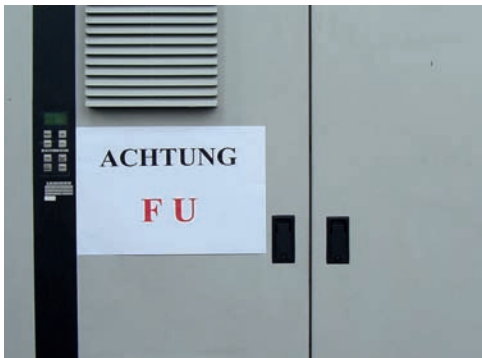
Abb. 6 Beispiel für die Kennzeichnung eines frequenzgesteuerten Krans, hier Anschlusschrank mit Frequenzumrichter (FU)
