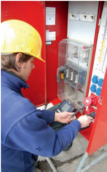
Abb. 10 Inbetriebnahmeprüfung eines Baustromverteilers nach VDE 0100-600
