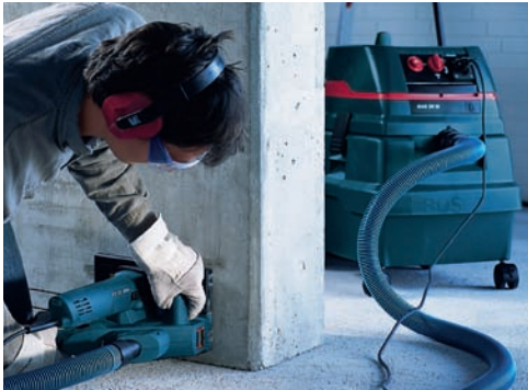
Abb. 14 Mauernutfräse mit Staubabsaugung
