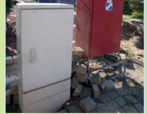
Kabelverteilerschrank
