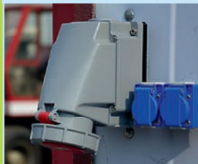
Steckdosen (unbekannte Schutzmaßnahme)
