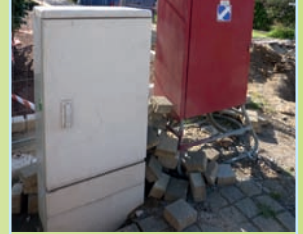
Kabelverteilerschrank
