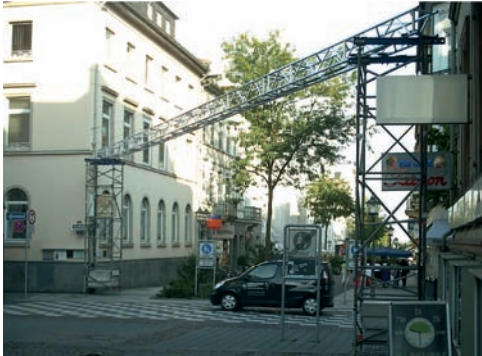
Abb. 1 Hochgelegte Leitung zur Straßenquerung
