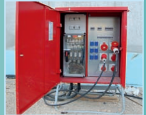
Baustromverteilerschrank
